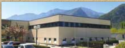
Stepan, Voreppe, réalisation IDBAT
